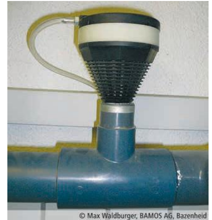
Վերահսկող սարքը վերահսկում է վակուումի մակարդակը:
