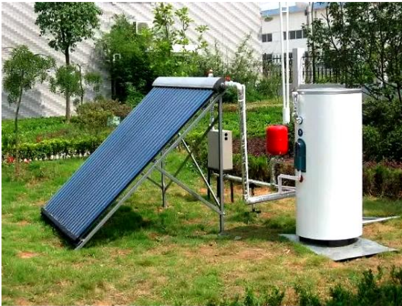
Նկար 19. Արևային ակտիվ ջրատաքացուցիչի ընդհանուր տեսքը
