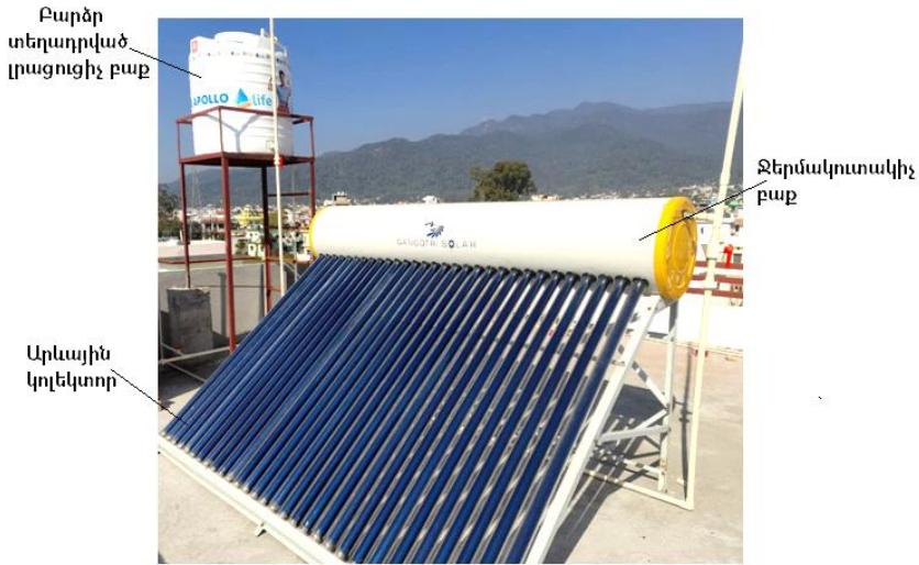
Նկար 10. Ավելի բարձր տեղադրված բաքով արևային պասիվ ջերմային կայանի ընդհանուր տեսքը
