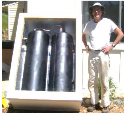
Նկար 12. Ներկառուցված կոլեկտոր-կուտակիչ բաքով արևային ջրատաքացուցիչը
